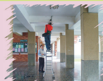
校園監視系統整修
